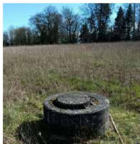
Puisard installé dans le champ AB39
