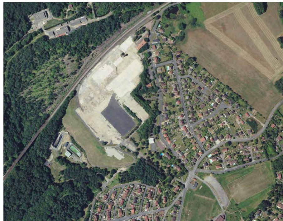
Vue aérienne de l'emprise du site suite au démantèlement des bâtiments
