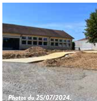
Pendant les travaux.
