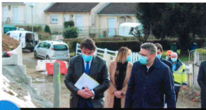
1 Visite du chantier du lotissement des Combeaux
