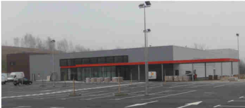
Le futur Super U en travaux
