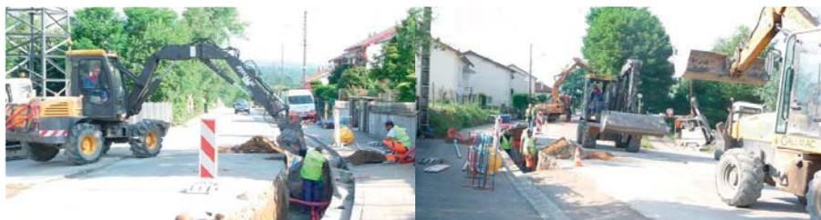
Travaux d'effacement des réseaux électriques et de télécommunications, éclairage public et remplacement des canalisations d'adduction d'eau potable avenue Maryse Bastié
