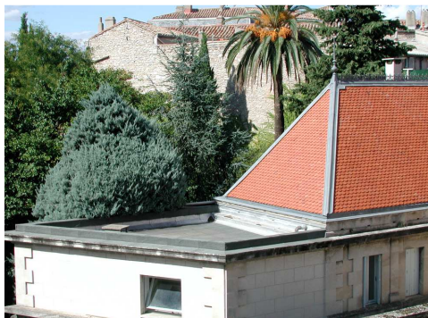
Toiture-terrasse non accessible d'un immeuble 19ème à Nîmes (30)
