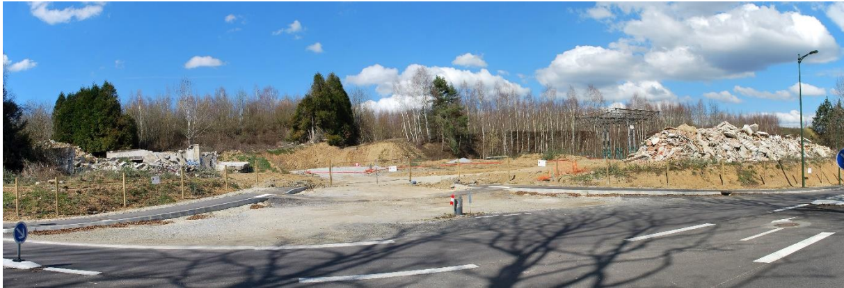
Ancien site Total en 2016 en cours de réaménagement
