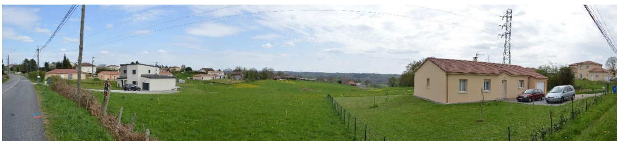
Photographie 9 : Constructions réalisées en 2011-2012 (au nord de Bournazeau)
