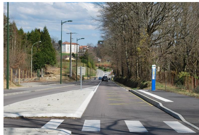
Arrêt TC existant le long du site sur la RD29
