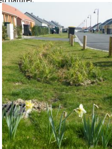
Les noues : ouvrages de rétention / infiltration des eaux pluviales
